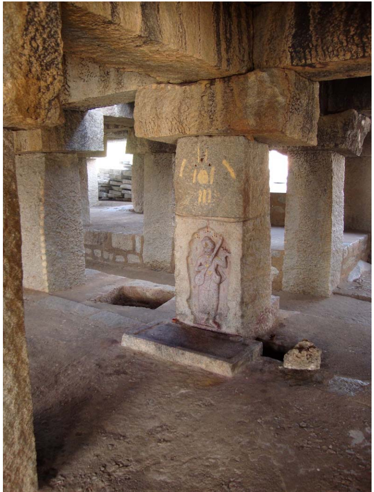
Abb. 13: Purandaras samādhi-Stätte im Purandara- maṅṭap (Hampi), 2013 (Bild: S. Bansal-Tönz)
